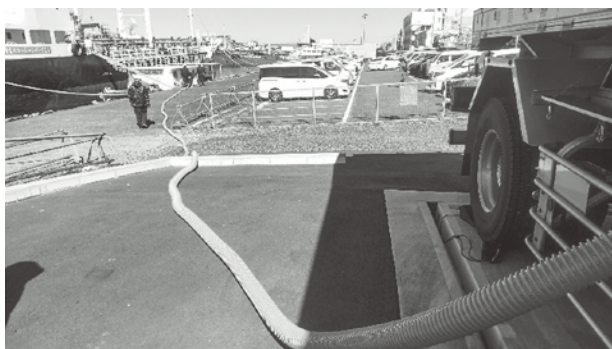
図-2 タンクローリーからバージへホース接続
