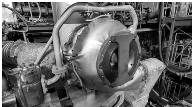
図-6 過給機カット試験の様子
