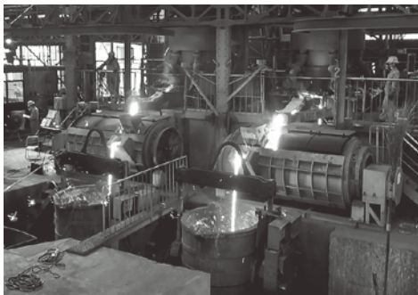
稼働中の冷風水冷式6t/hキュボラ2基
