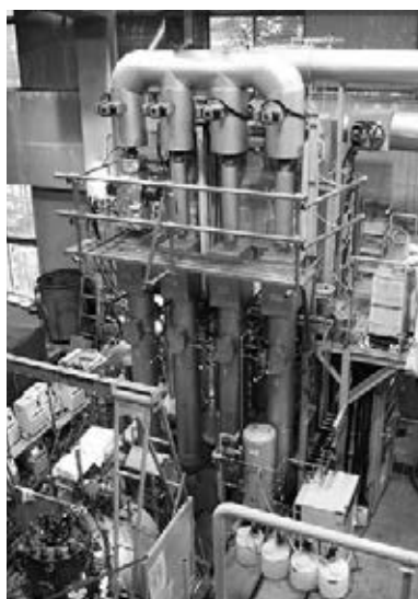
図-4 分流型 SCR 装置
