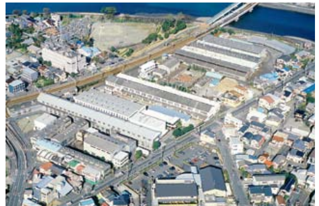
中港工場全景
