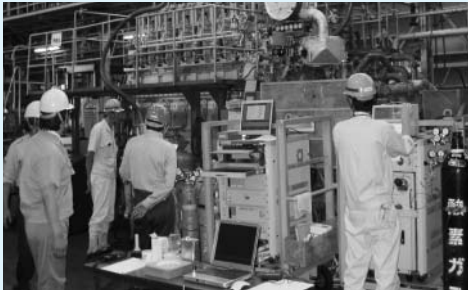
JG殿立会いによるNOx放出量確認運転
