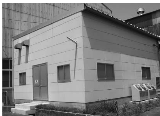
写真-3 受電・変電室
