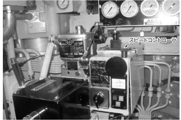
写真-1 機関取付け状況
